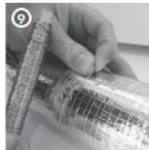
**PL** Zalecane jest dodatkowo zabezpieczenie otuliny drutem ocynkowanym. W szczególności przy temperaturach powyżej 40°C, a także instalacjach w miejscach niedostępnych otuliny należy zabezpieczyć drutem wiążącym.
